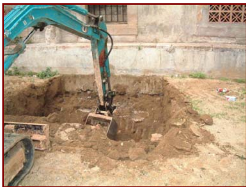
Inici dels treballs realitzats a la cala 2.
