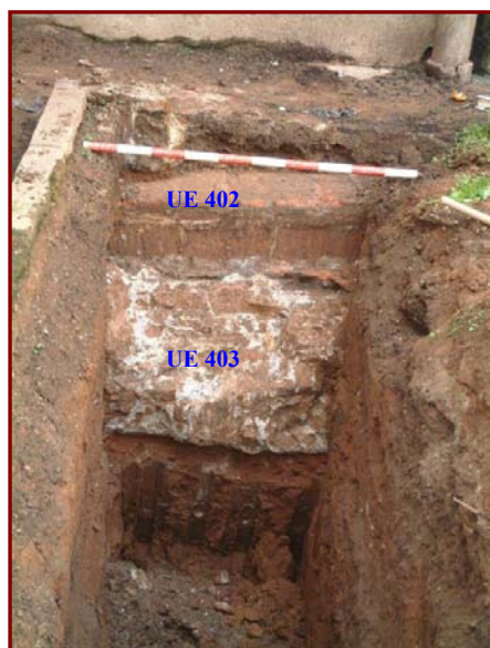
Imatge a on es pot apreciar la canalització UE 402 i sota la fonamentació UE 403.
