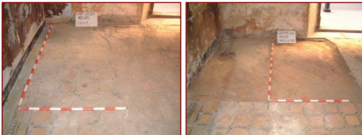
A l'esquerra imatge del paviment UE 301 i a la dreta s'identifica el paviment UE 302
